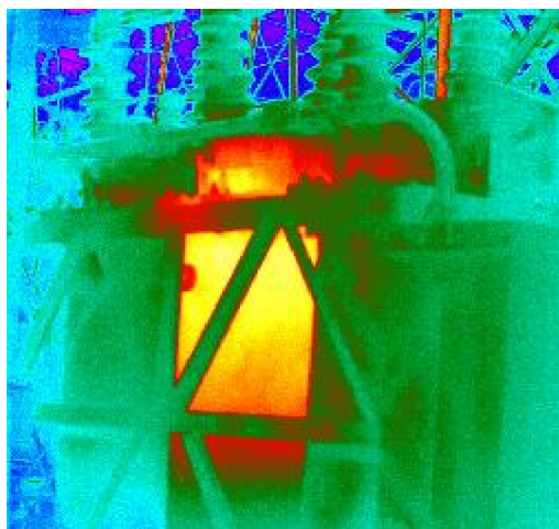
Surriscaldamento di un avvolgimento di un trasformatore dovuto a un problema di raffreddamento
